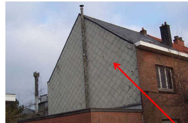
Ardoises et cheminée
